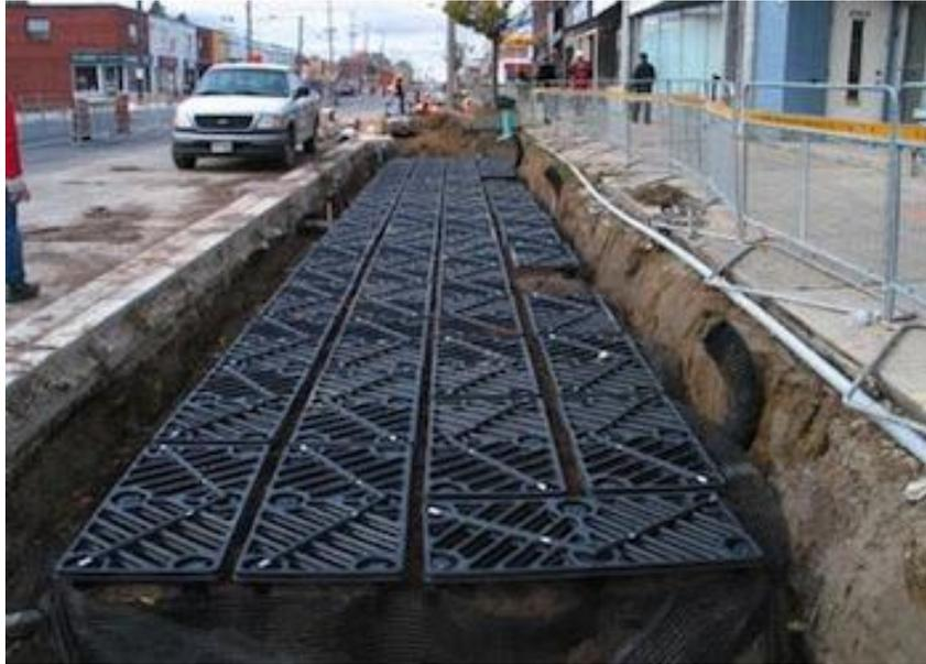
*Figura 12 – Esempio di realizzazione di una vasca di accumulo con elementi prefabbricati in polipropilene sotto il piano stradale*
