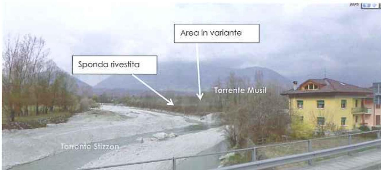
Figura 5 – Muro d'argine rivestito in massi in sinistra Stizzon
