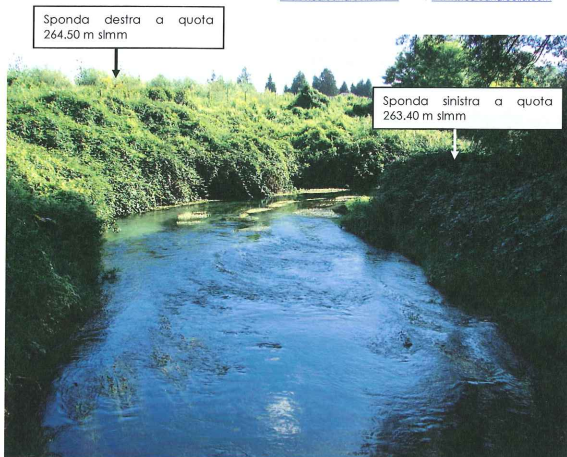
Figura 11 – Torrente Musil a valle del ponte di Via Stizzon
