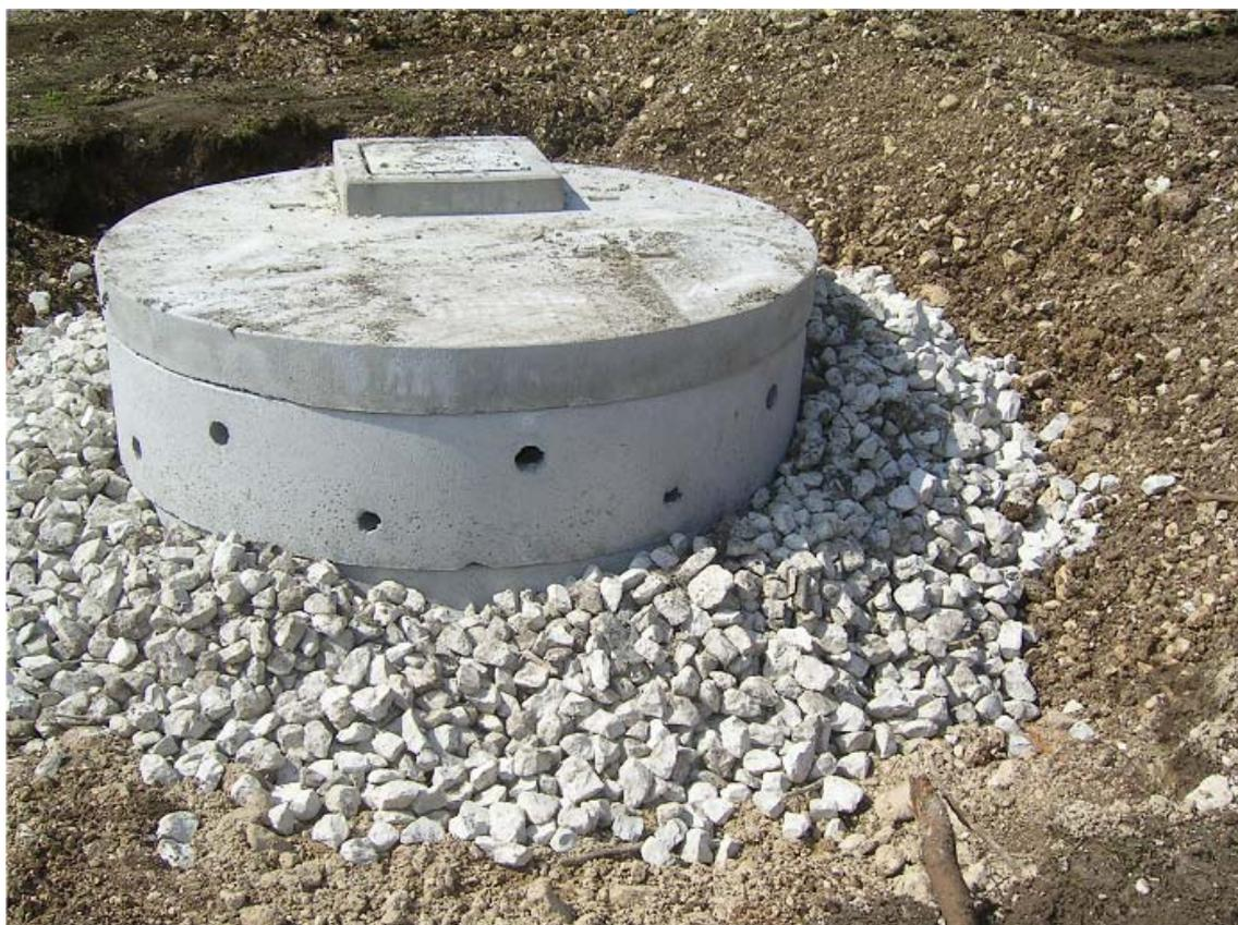
*Figura 6 – Esempio di pozzo perdente per la re immissione dei deflussi in falda*
