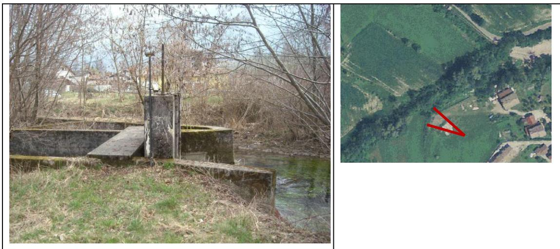
Figura 8 – Paratoia di derivazione delle risorgive verso il molino Stien
