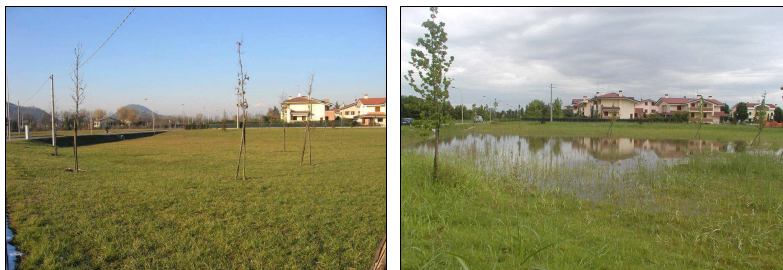
Volume di invaso ricavato tramite depressioni in aree verdi, in periodo secco (a sinistra) e durante una piena (a destra)
