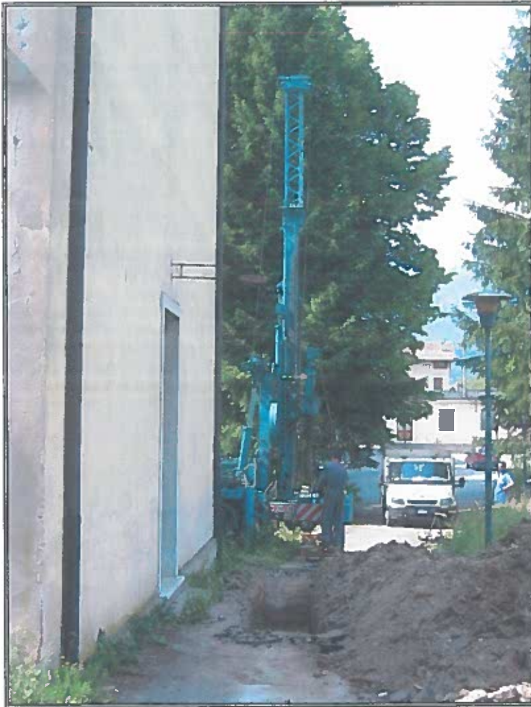
Foto 1. Ubicazione e realizzazione del sondaggio S1
