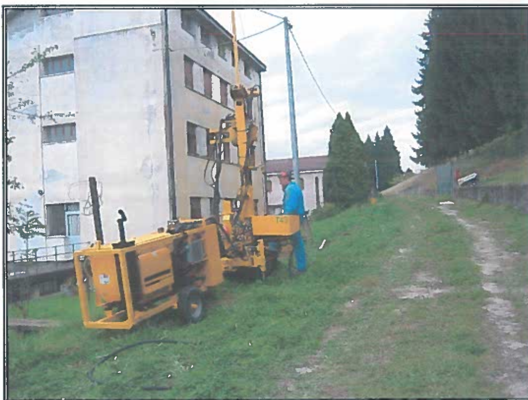
Foto 15. Ubicazione e realizzazione del sondaggio S7
