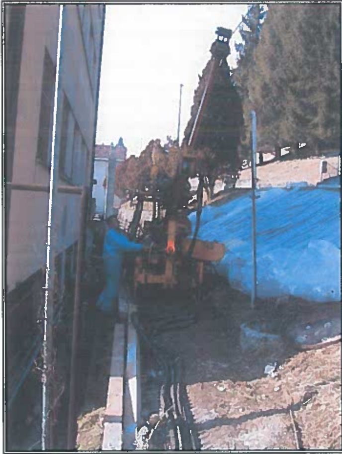
Foto 8. Ubicazione e realizzazione del sondaggio S4
