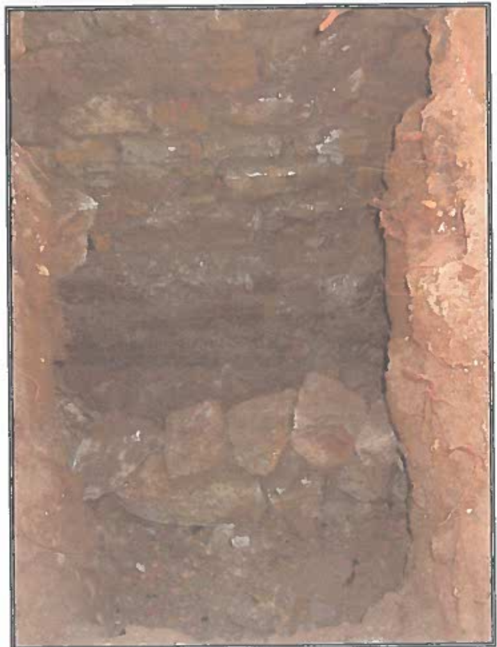
Foto 22, Muro a secco, dello spessore di 1 metro e pareti sempre in sassi della canaletta di drenaggio
