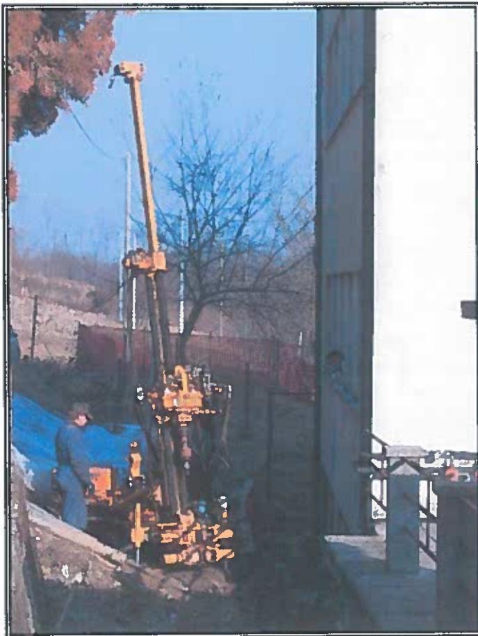
Foto 4. Ubicazione e realizzazione del sondaggio S2
