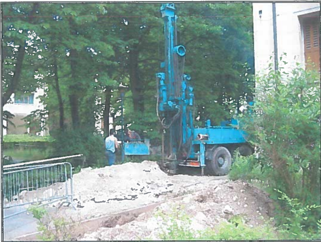
Foto 9. Ubicazione e realizzazione del sondaggio S3
