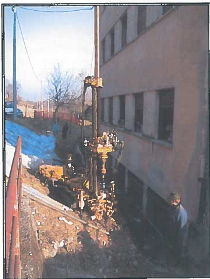
Foto 6. Ubicazione e realizzazione del sondaggio S3
