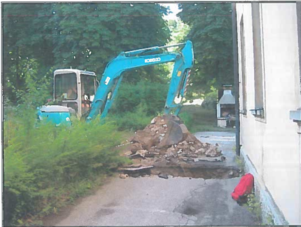
Foto 25. Ubicazione e realizzazione dello scavo S6a posto in corrispondenza del prospetto est dell'edificio denominato Unità 5
