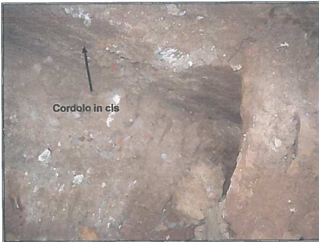
Foto 23. Canaletta di drenaggio e cordolo in cls dello spessore di 50 cm posto alla base della fondazione
