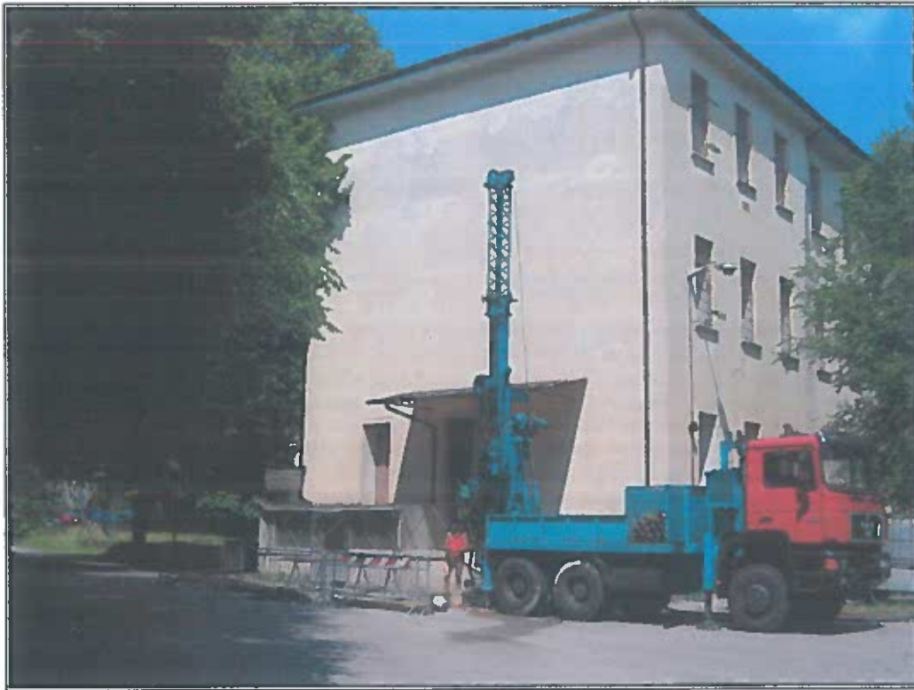
Foto 15. Ubicazione e realizzazione del sondaggio S4
