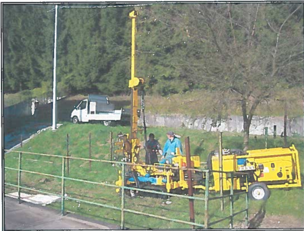
Foto 20. Ubicazione e realizzazione del sondaggio S9
