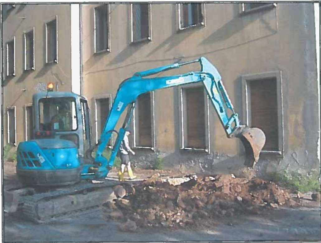
Foto 20. Sondaggio S5a sulle fondazioni in corrispondenza del prospetto sud dell'Unità 6
