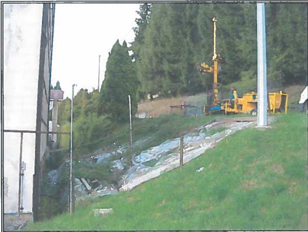
Foto 12. Ubicazione e realizzazione del sondaggio S6
