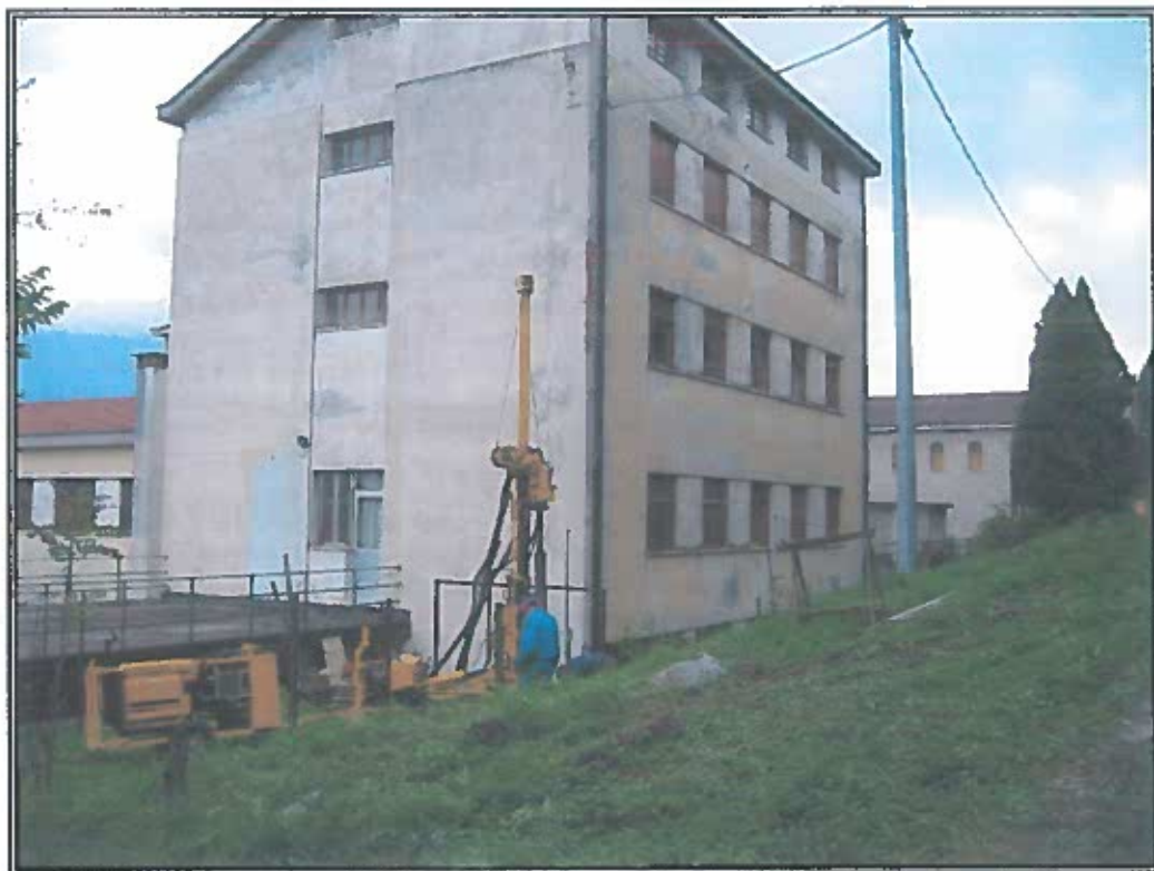
Foto 17. Ubicazione e realizzazione del sondaggio S8
