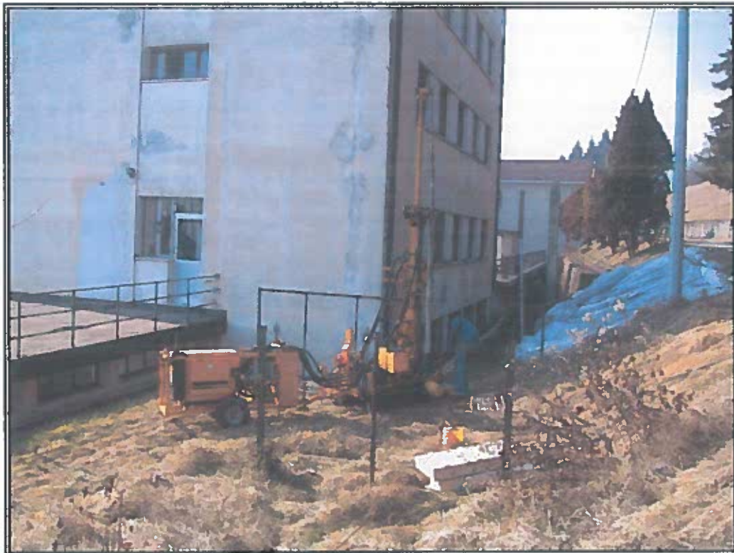
Foto 1. Ubicazione e realizzazione del sondaggio S1
