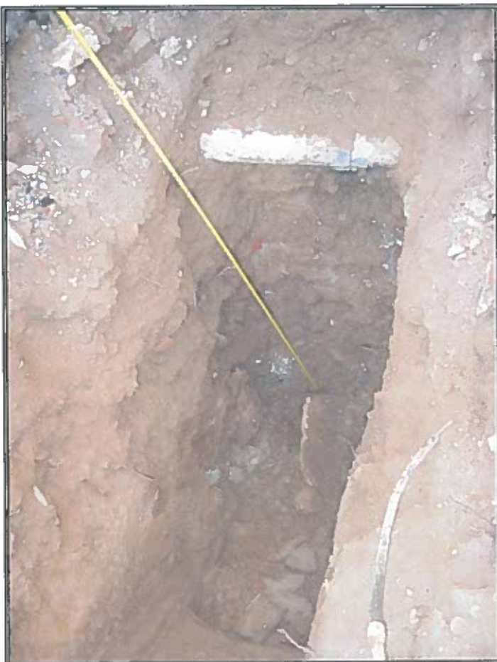
Foto 26. Sondaggio effettuato fino a - 2.40 metri di profondità dal piano campagna; è visibile il tubo di allontanamento delle acque pluviali e a fondo scavo la copertura della canaletta di drenaggio in sassi
