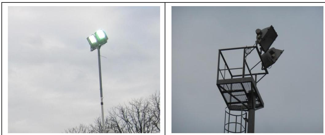
*Figura 6 Esempi di proiettori la cui conformità alla L.R. 17/09 deve essere valutata in funzione del contesto di utilizzo e degli orari di accensione*
