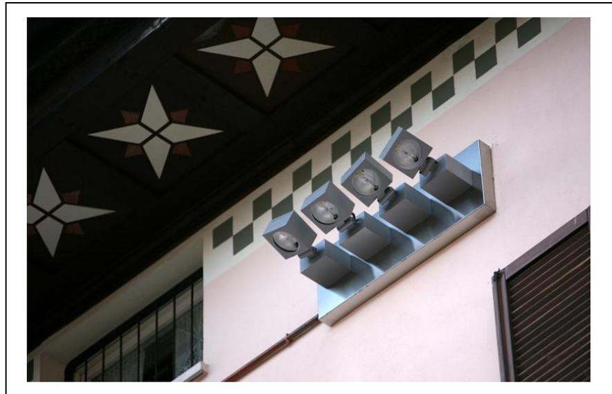
*Figura 17 Esempio di piastra a parete con proiettori*
