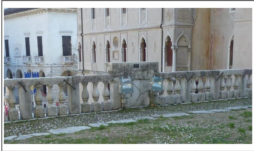
*Figura 16 Proiettori al sodio alta pressione per l'illuminazione della Chiesa*
