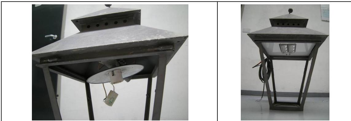
Figura 14 Esempio di intervento di retrofit di una lanterna
